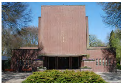
Bebouwing op begraafplaatsen is veelal zorgvuldig gedetailleerd
